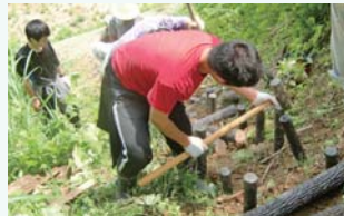
豪雪で壊れてしまった階段の修復作業の様子
