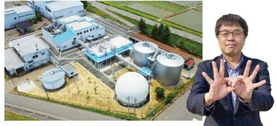
長岡市生ごみバイオガス化事業の理念に共感し、設計・建設から運営・維持管理までを一括して行っています。生ごみを発酵させてバイオガスを取り出し、発電した電力を再生可能エネルギーとして販売。発電した電力の一部は電気自動車充電用として市民に還元しています。また、発酵残渣は補助燃料として有効利用し、今後は肥料としての活用も検討しています。これからも資源循環型社会の実現に貢献したいです。
