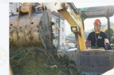
2023年11月福島県いわき市豪雨災害現場での土砂撤去作業。
