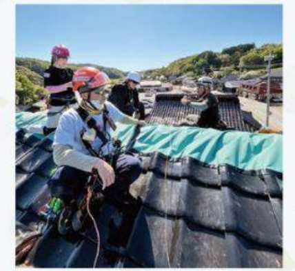
2023年5月石川県奥能登半島地震で被害を受けた五層屋根の補修作業。
